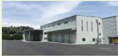
カントリーエレベーター
