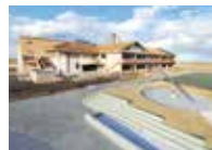
山元町震災遺構 中浜小学校
